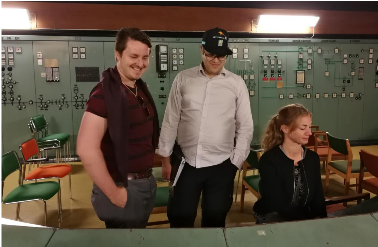
Delar av gruppen undersöker det gamla kontrollrummet. Stor skillnad jämfört med det numera tomma i R2. Källa: Katrin Ahlford
