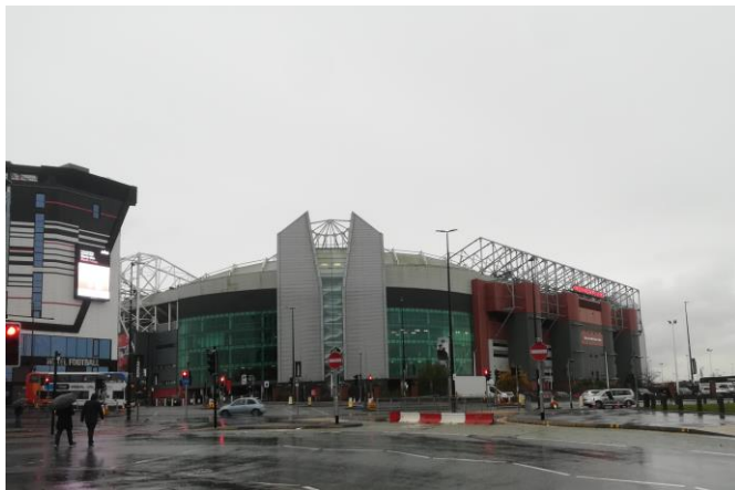
Figur 5: Vädret i Manchester bjöd inte på några överraskningar
