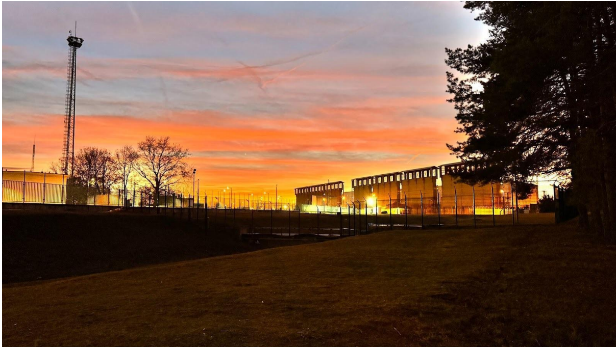
Bild 1 RHK:s mellanförvar av använt kärnbränsle. På bilden syns frånluftsschakten som reser sig som skorstenar på byggnaden. Bildkälla: https://rhk.hu/en
