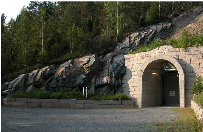
Bild 1. Låg och mellanaktivt radioaktivt avfall deponeras i denna anläggning i Himdalen Foto: norskdekommisjonering.no
