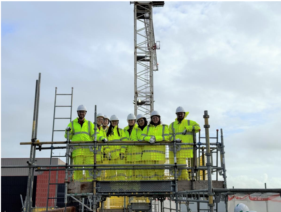
Figur 3. Högst upp på nybygget av Sellafield Retreatment plant var det fin utsikt över anläggningen.
