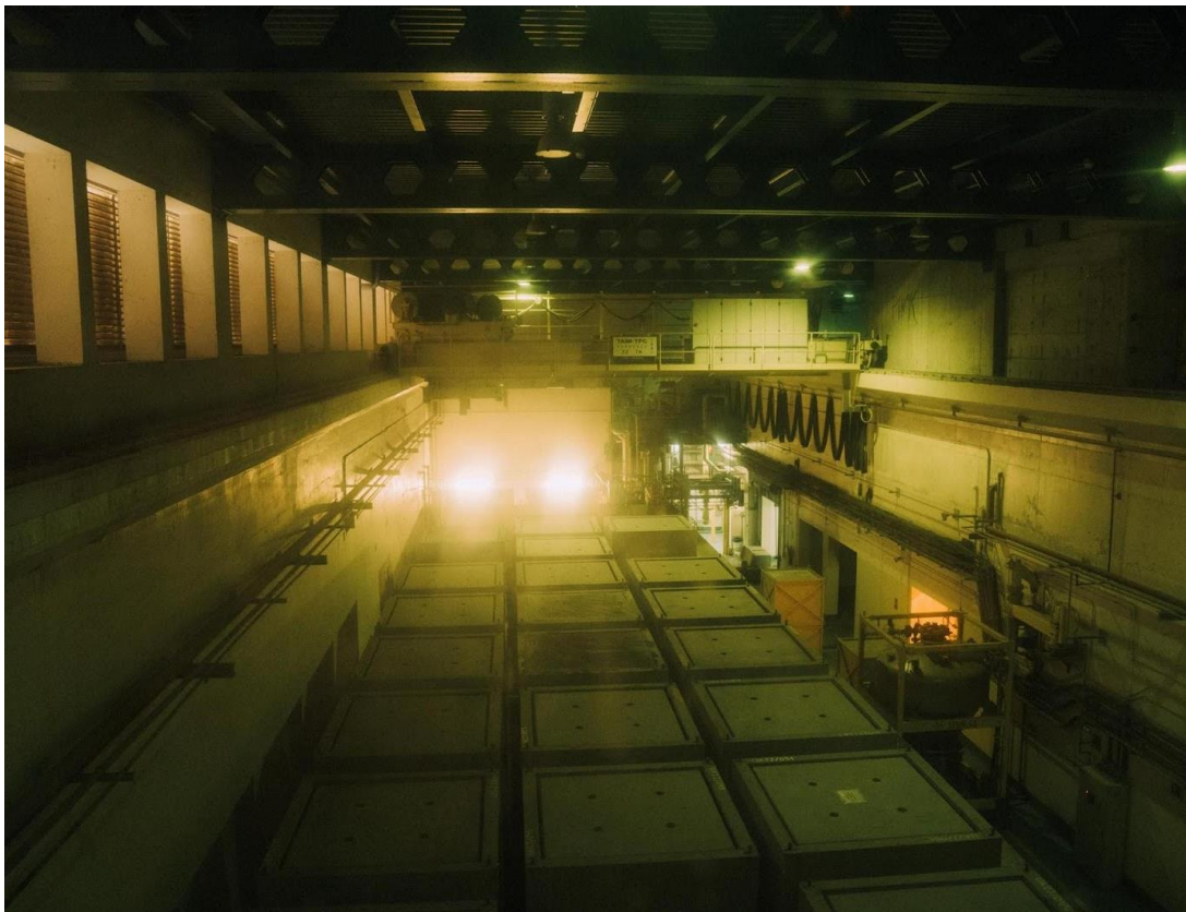
Bild på hallen där kringgjutning utförs (källa: epe.es).
