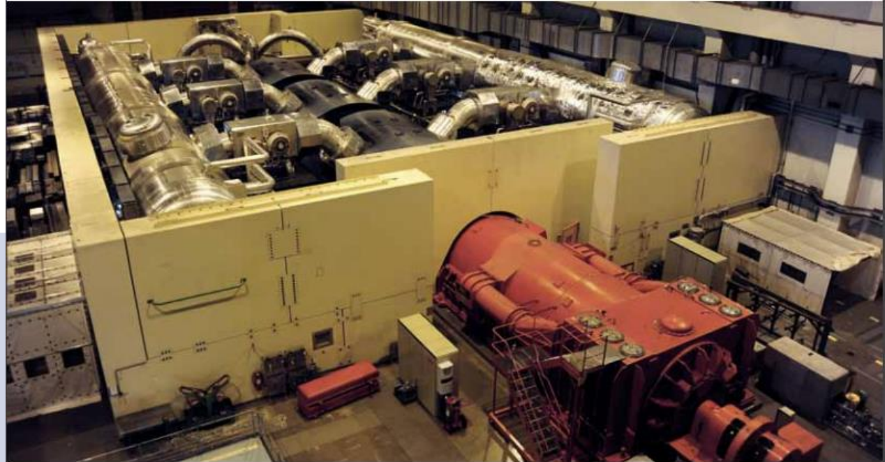
Turbinhallen som huserar världens största 2-poliga generator.
