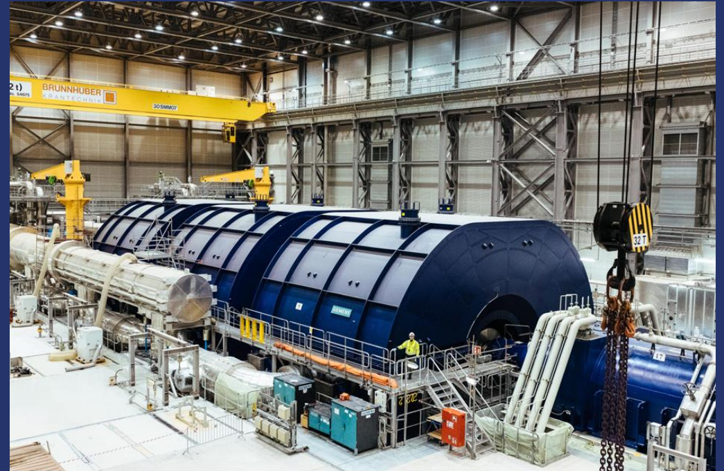
OL3 högtrycksturbin. Bild från TVOs bildbank.
