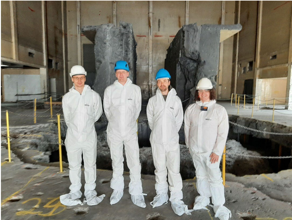
Figur 2: Bild från reaktorhallen på R2. Endast delar av betongkonstruktionen som tidigare utgjorde reaktorbasäng kvarstår.
