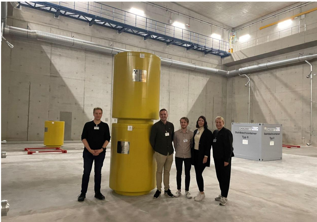
I det nybyggda mellanförvaringslagret LasmAaz (Lager für schwach- und mittelradioaktive Abfälle)
