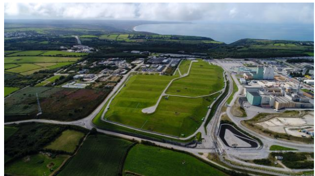
Sitens nuvarande utseende. Det skyddande tätskiktet är nu gräsbevuxet.
