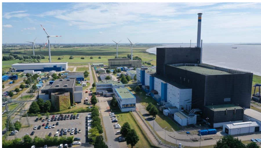
Figur 7 Överblicksbild av site
