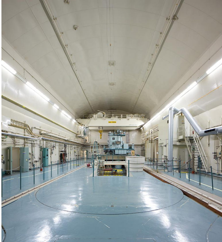
Figur 1 Reaktorhall Ågesta, innan NoR (Nedmontering och Rivning)
