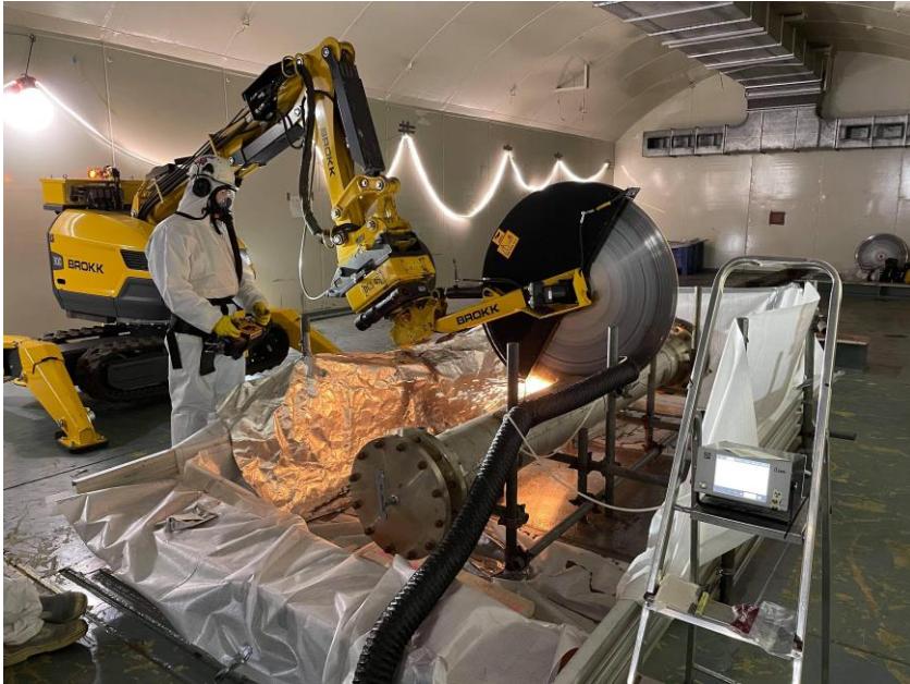
Figur 2 Nicklas i arbete med rivningsrobot (Brokk) i Ågesta
