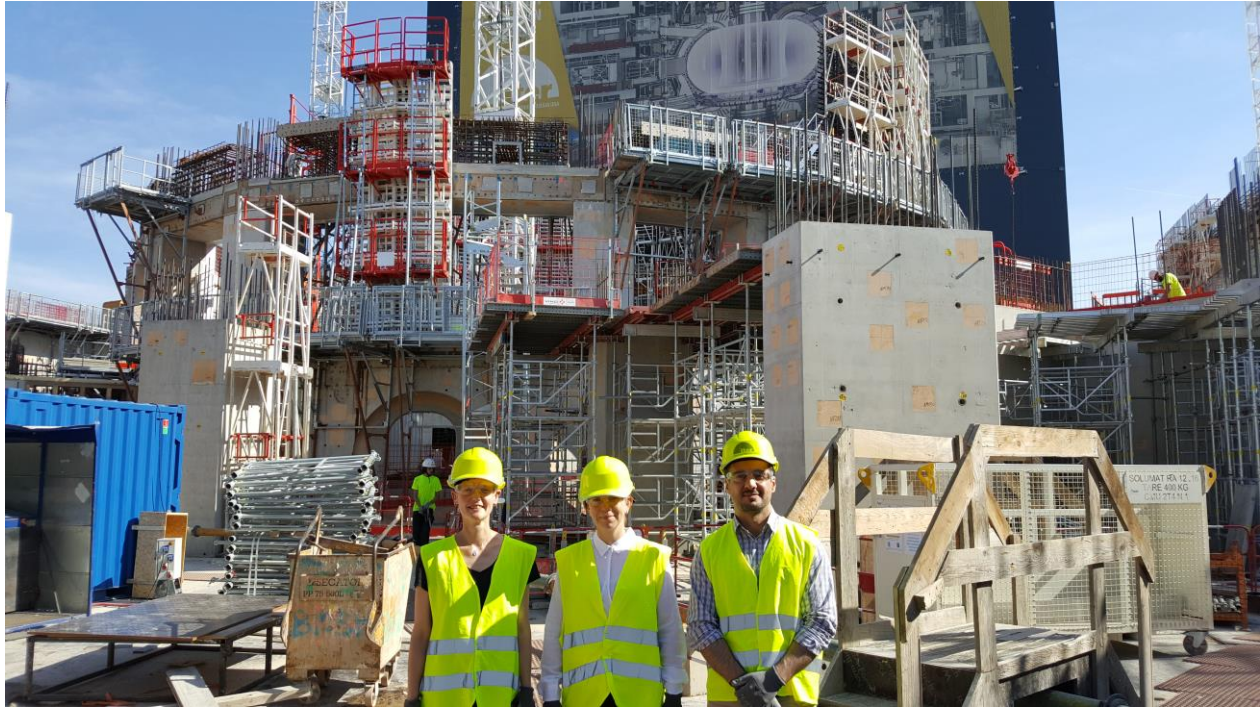
Figur 3. YG-gruppen vid byggnationen av tokamakbyggnaden, ITER.
