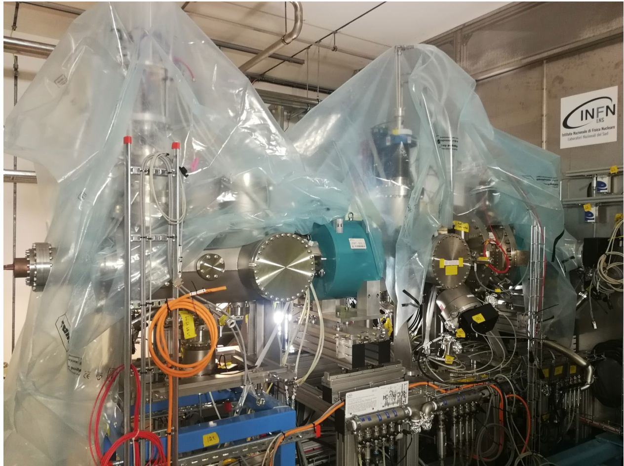
ESS protonkälla, på plats och under inkoppling.
